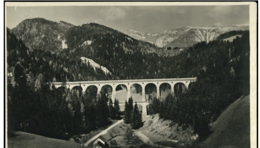
Kalte-Rinne-Viadukt 1928 an die Rax 2000m.
