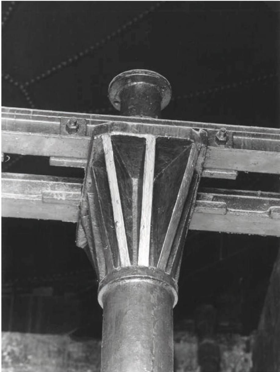
Waidbruck, Wasserstation. Kapitel aus Eisen. Eine der beiden Säulen, die den Kessel stützten und zugleich als Wasserleitungen dienten. 1991, Foto Walter Niedermayr
