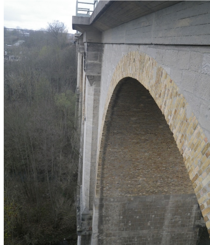
Weimar, EÜ Ilmtalviadukt
