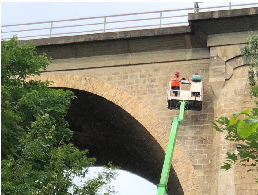
Mauerwerkssondierung Ilmtalviadukt Weimar
