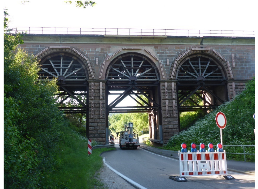
Pleinfeld, EÜ Höhbachviadukt
