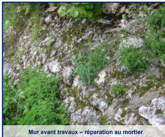
Remise en état d'un mur de soutènement en pierres sèches sur le domaine ferroviaire
