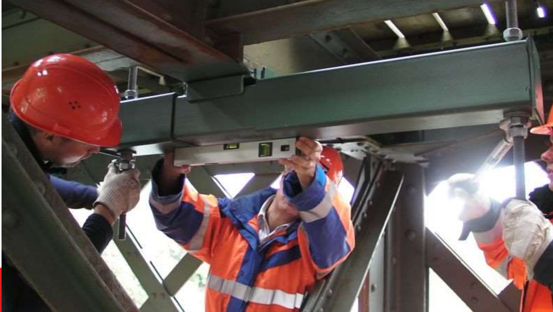
Montage der Verspannung
