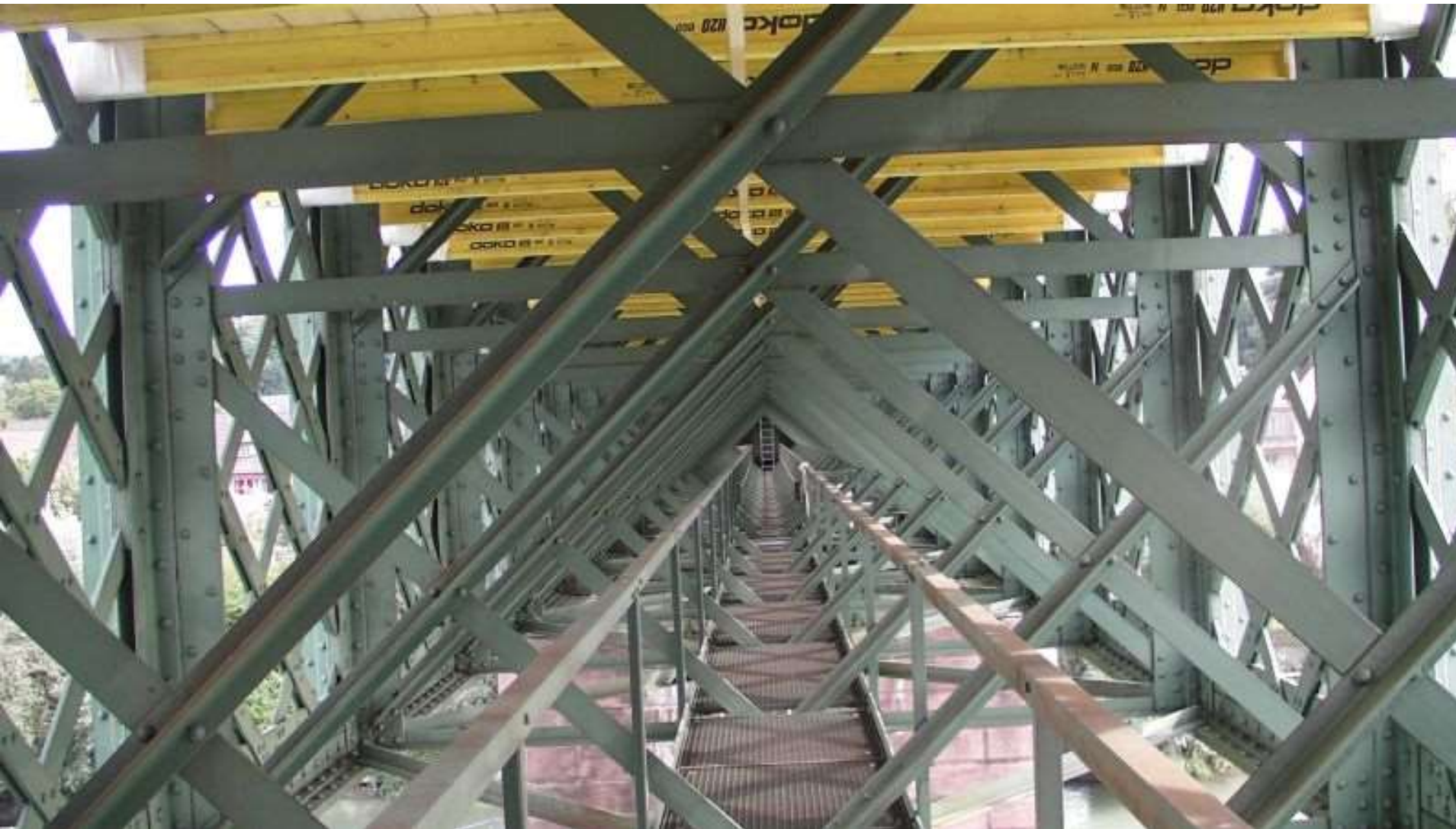
Brücke mit Arbeitsboden
