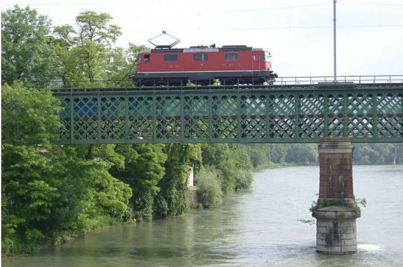
Belastungslok Re 4/4“ auf der Rheinbrücke
