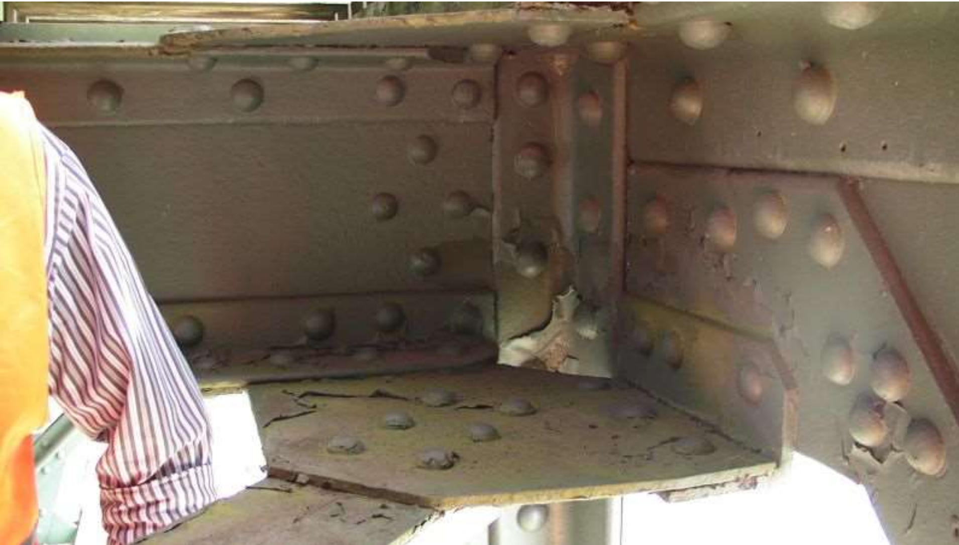
Brücke Obergurt, Windverband
