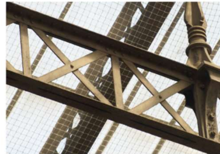
Gare de Paris Austerlitz . Photo: SNCF-AREP.
